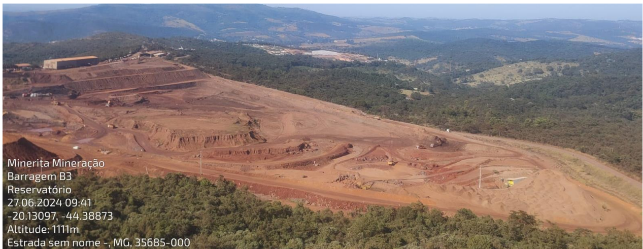
Escavação realizada por conjuntos escavadeiras e caminhões basculantes.
